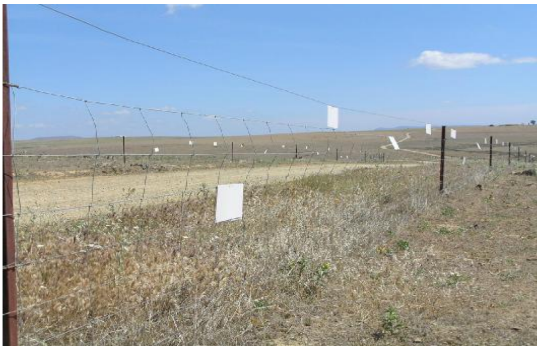
Foto n° 4: Sustitución de alambre de espino, colocación de malla ganadera y señalización. Anteriormente, este tendido era de alambre de espino.
