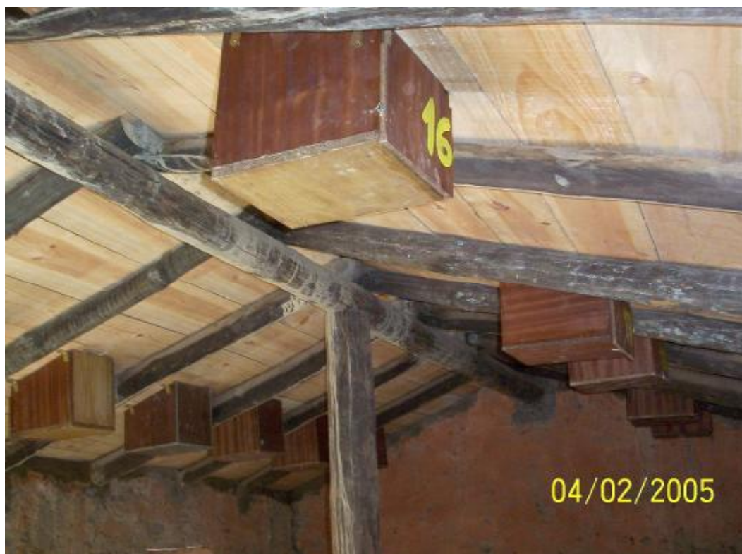
Foto nº 7: Detalle de la colocación de las cajas nido en el interior de la cubierta de “Valle Sevilla”.
