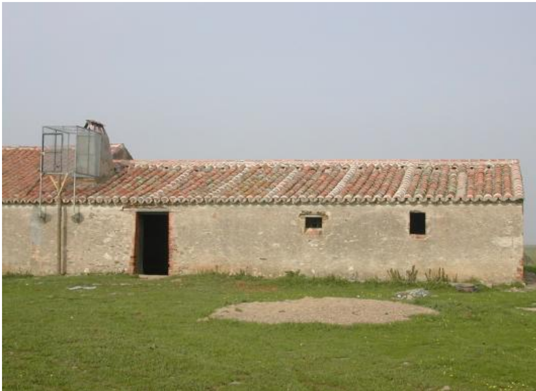
Foto n° 4: Jaulón para “ambiente de colonia” y “hacking” en la cubierta de “Villaralto”.
