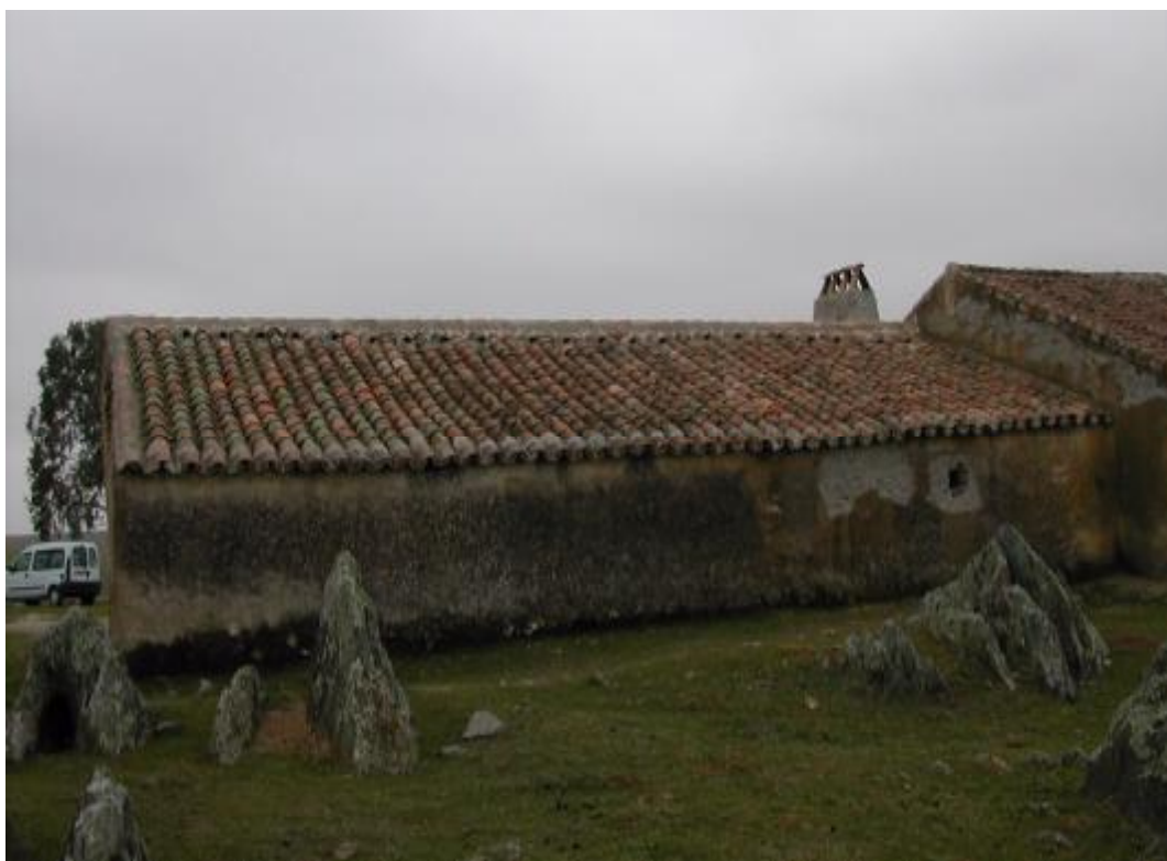
Foto nº 2: Estado de la cubierta de “Villaralto” después de la rehabilitación.
