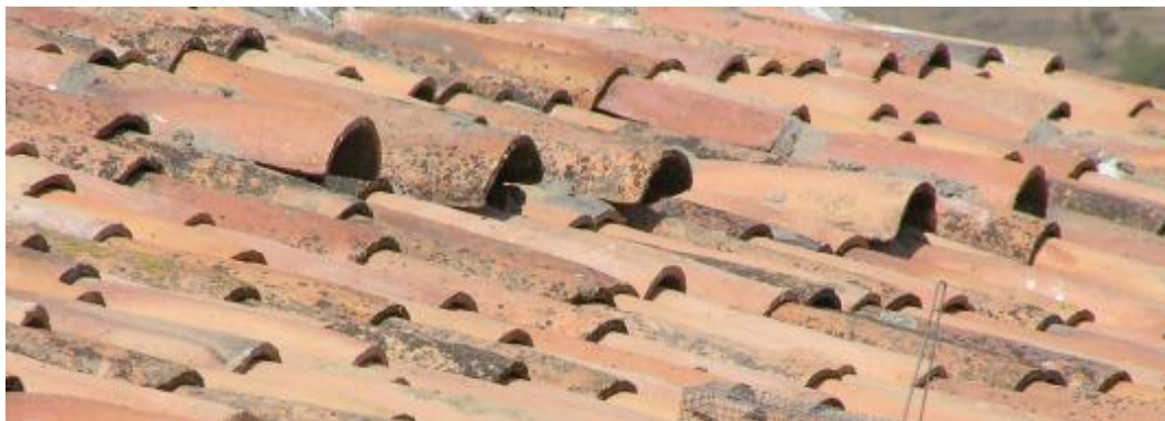
Foto nº 16: Detalle de las entradas a las cajas nido en la cubierta de “Valle Sevilla”.
