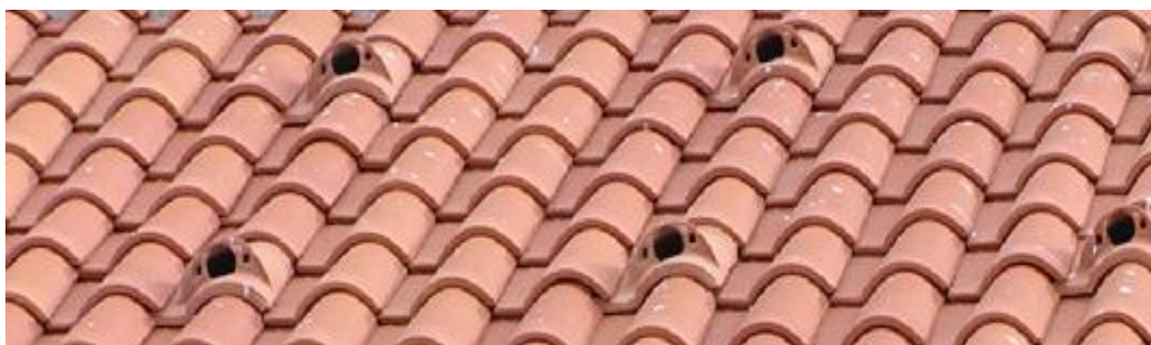
Foto nº 18: Detalle de entradas a las cajas nido en la cubierta de “Valle de los Santos”.
