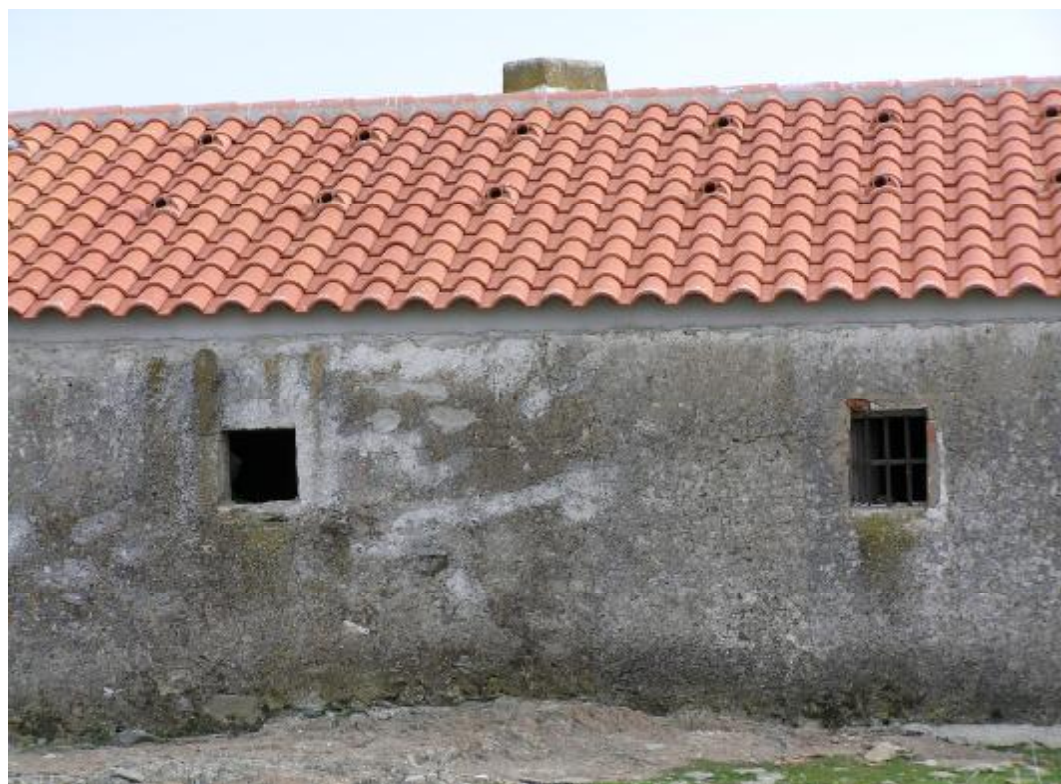
Foto nº 10: Casa de “Valle de los Santos” después de la rehabilitación.
