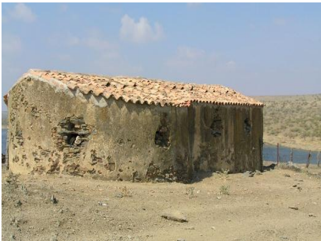
Foto nº 6: Establo de “Valle Sevilla” después de la rehabilitación.
