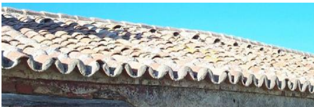
Foto nº 17: Detalle de entradas a las cajas nido en la cubierta de “Villaralto”.
