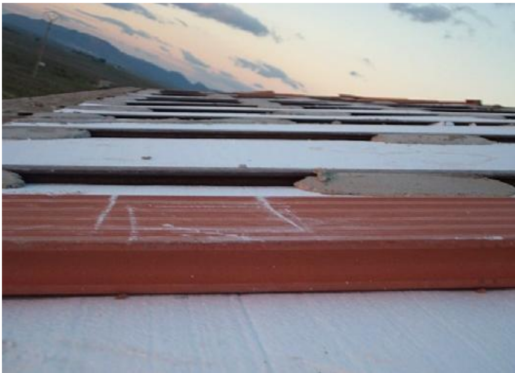
Foto n° 11: Detalle de planchas aislantes de poliespán en “Valle de los Santos” .
