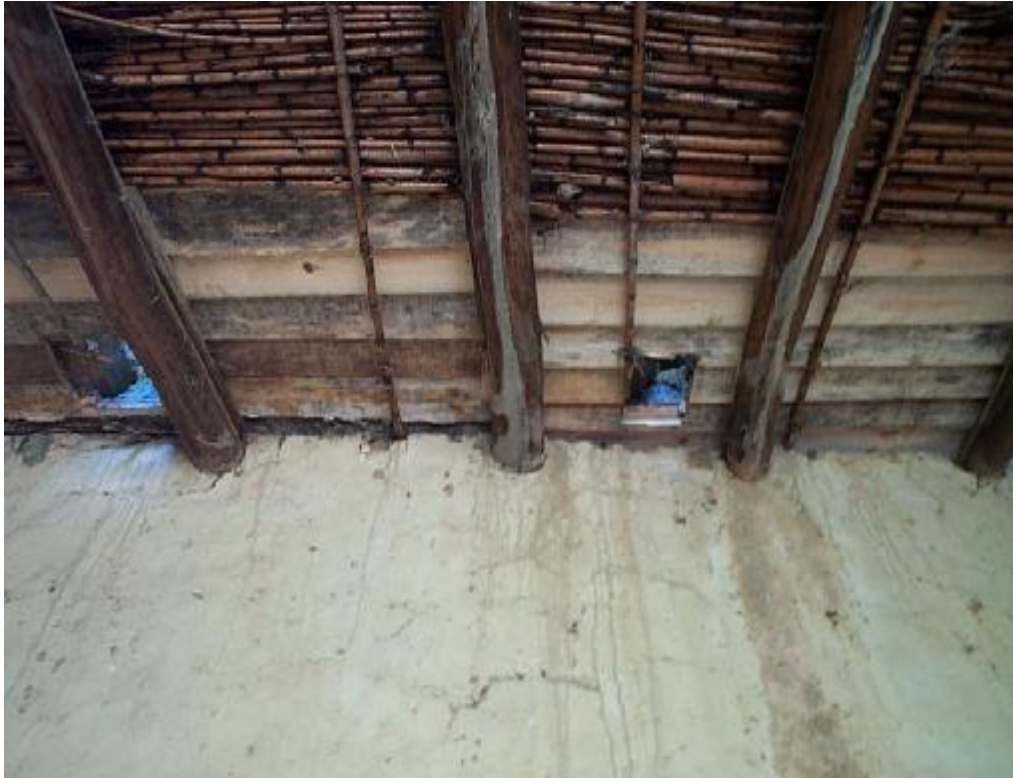
Foto n° 3: Detalle del hueco dejado para la entrada a los nidos en el tejado de “Villaralto”.
