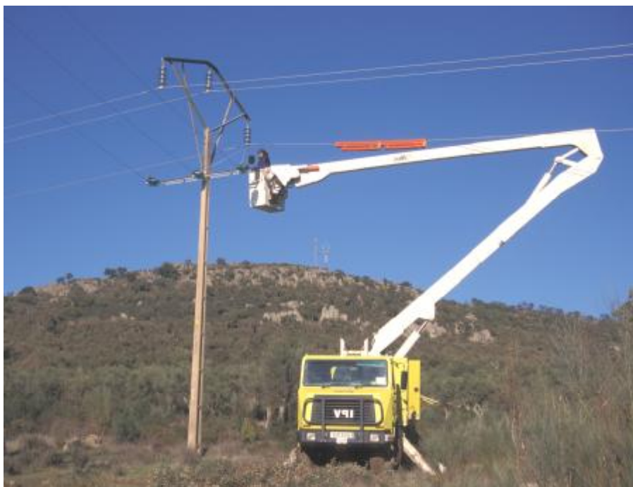
Foto n° 7: Trabajos de modificación de apoyos eléctricos sin tensión.
