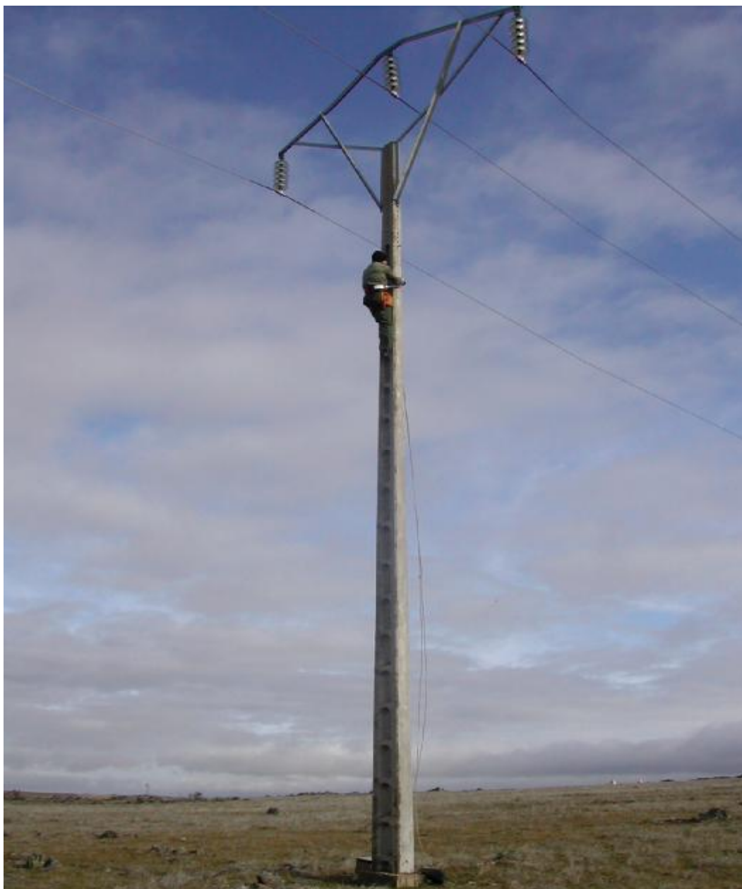
Foto n° 1: Proceso de colocación de caja nido en apoyo eléctrico
