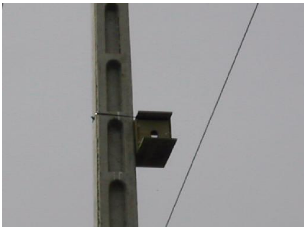
Foto n° 2: Detalle de apoyos de alineación con cajas nido.
