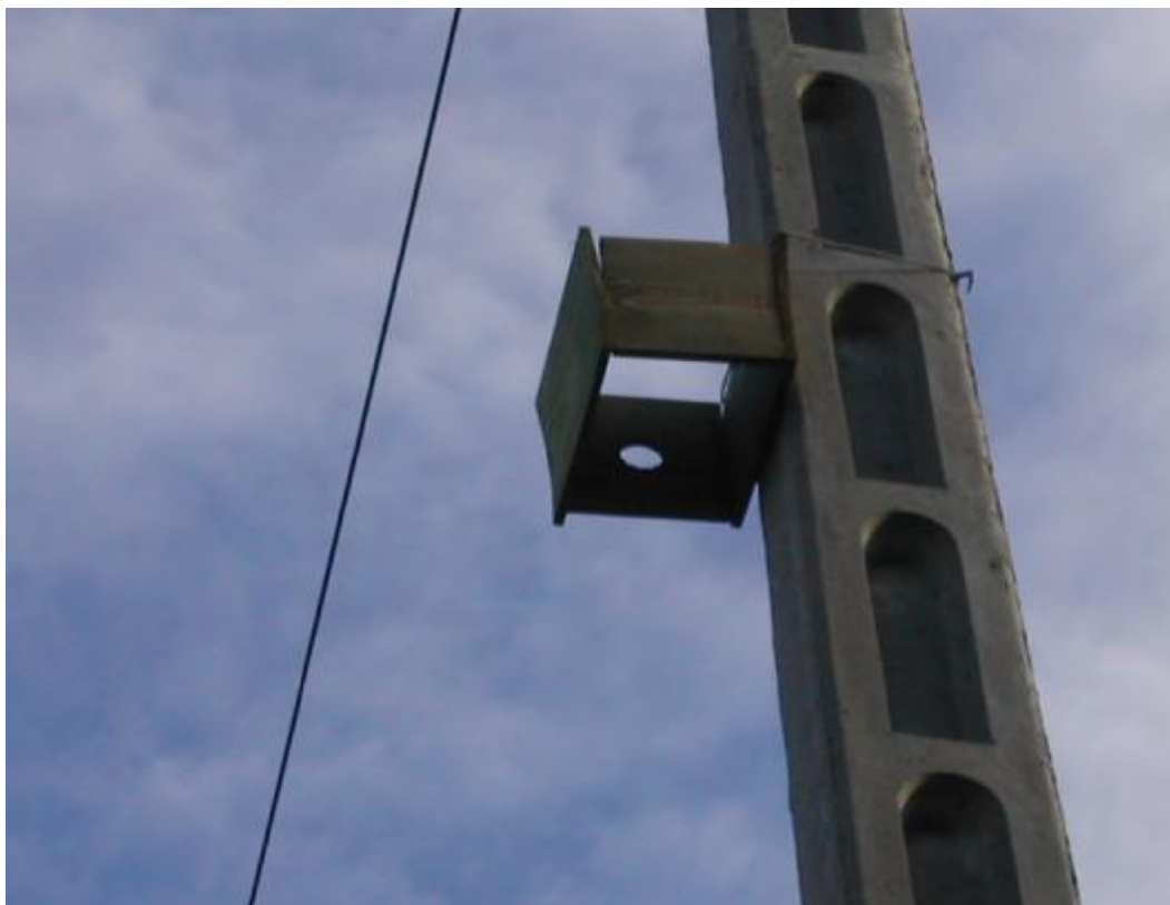
Foto n° 3: Detalle de caja nido y mecanismo de sujeción al apoyo.
