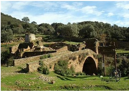
12. Torreta de toma de agua en las proximidades de la mina de Teba
