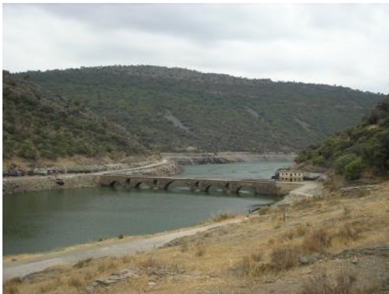
8. El puente de El Cardenal
